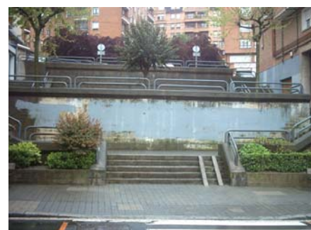
Escaleras mal iluminadas
